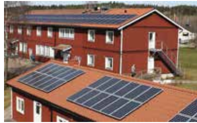
Solceller. Foto: Nordic Solar
